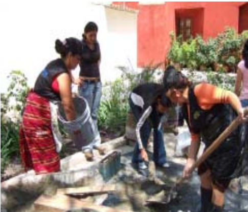
Un grupo de mujeres indígenas construye viviendas antisísmicas, Guatemala, marzo de 2008, Federación Internacional de la Cruz Roja y de la Media Luna Roja, Provention. Fuente: Informe ProVenti3n 2008
