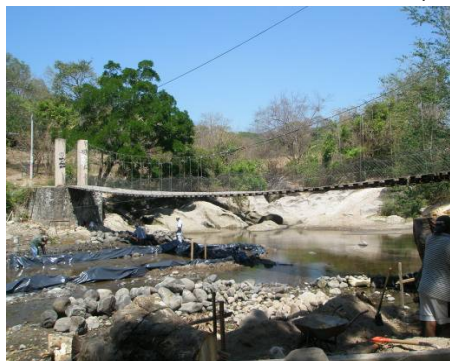
Foto 2.-Puente peatonal, vía de acceso al cantón El Paredón, municipio de San Pedro Masahuat.
